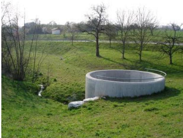
Zur Verbesserung des Hochwasserschutzes der Gemeinden im Nordraum von Reutlingen wurden nach dem Augusthochwasser 2002 unter anderem drei Rückhaltebecken gebaut; die Rückhaltebecken Luiben (oben links) und Täle (oben rechts) liegen am Erlenbach, das Rückhaltebecken Mahden (unten links) liegt am Mahdenbach. Der Abfluss der Gewässer wird durch ein Bauwerk gedrosselt und ein Teil des Hochwasserabflusses wird durch die Dammbauwerke zurück gehalten.
