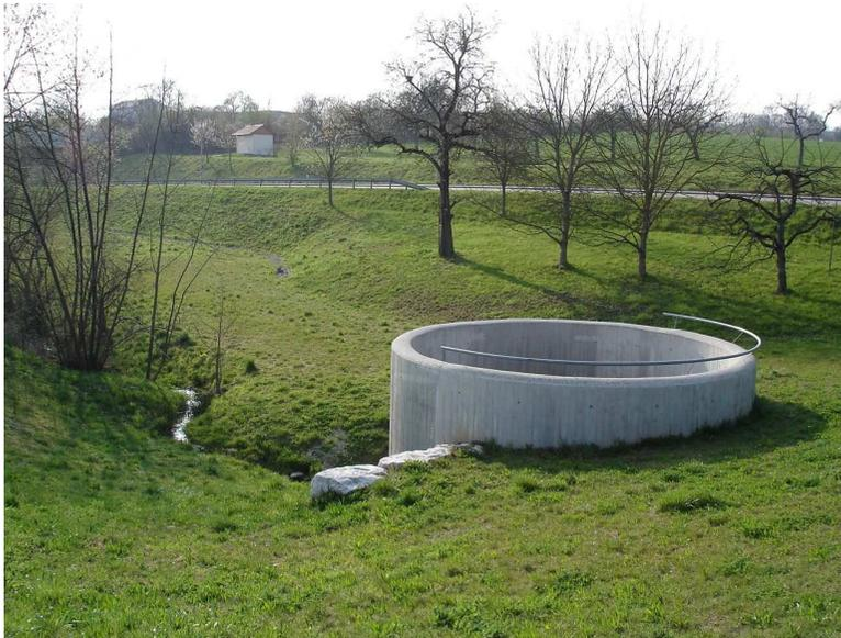
Zur Verbesserung des Hochwasserschutzes der Gemeinden im Nordraum von Reutlingen wurden nach dem Auguthochwasser 2002 unter anderem drei Rückhaltebecken gebaut; die Rückhaltebecken Luiben (oben links) und Täle (oben rechts) liegen am Erlenbach, das Rückhaltebecken Mahden (unten links) liegt am Mahdenbach. Der Abfluss der Gewässer wird durch ein Bauwerk gedrosselt und ein Teil des Hochwasserabflusses wird durch die Dammbauwerke zurück gehalten.
