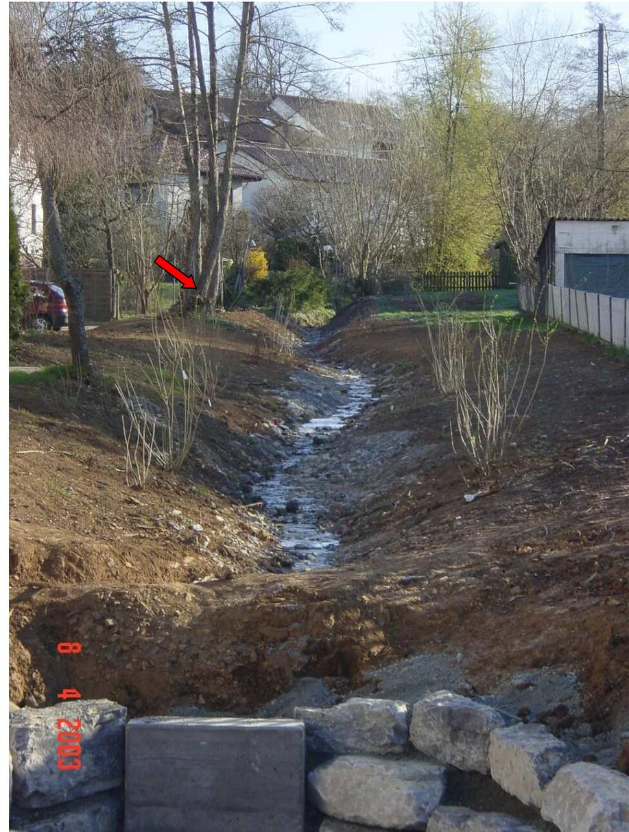
Bild rechts: Durch den Abbruch des Schuppens konnte der Klingwiesenbach verlegt, geöffnet und aufgeweitet werden (Verlauf jetzt rechts von der markierten Baumgruppe). Der Hochwasserabfluss wurde deutlich verbessert.
