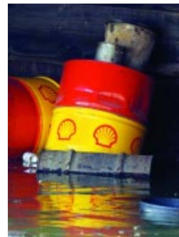
Stoffen (insbesondere Heizöl) zu treffen sind, rasch identifiziert werden. Gerade die hochwassersichere Lagerung von Heizöl baut sowohl großen finanziellen wie auch ökologischen Schäden vor und entlastet die Einsatzkräfte im Hochwasserfall.
