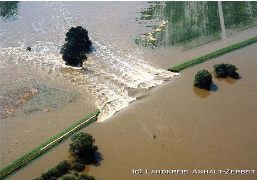
Abbildung 24: Deichbruch während des Hochwassers an Elbe und Mulde 2002
