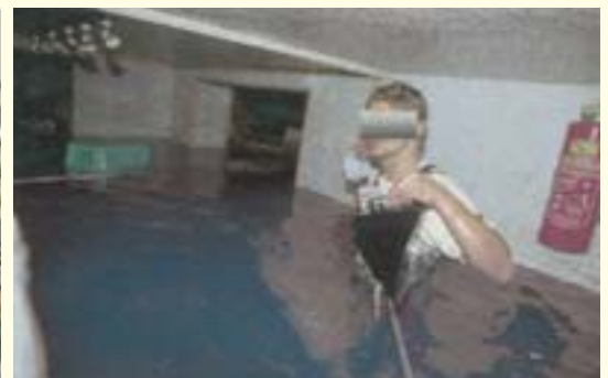
Ausgelaufenes Heizöl im Keller eines Wohnhauses
