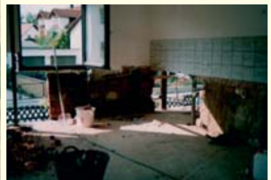
Mauerwerksaustausch infolge Ölverschmutzung (Kelheim 1999)
