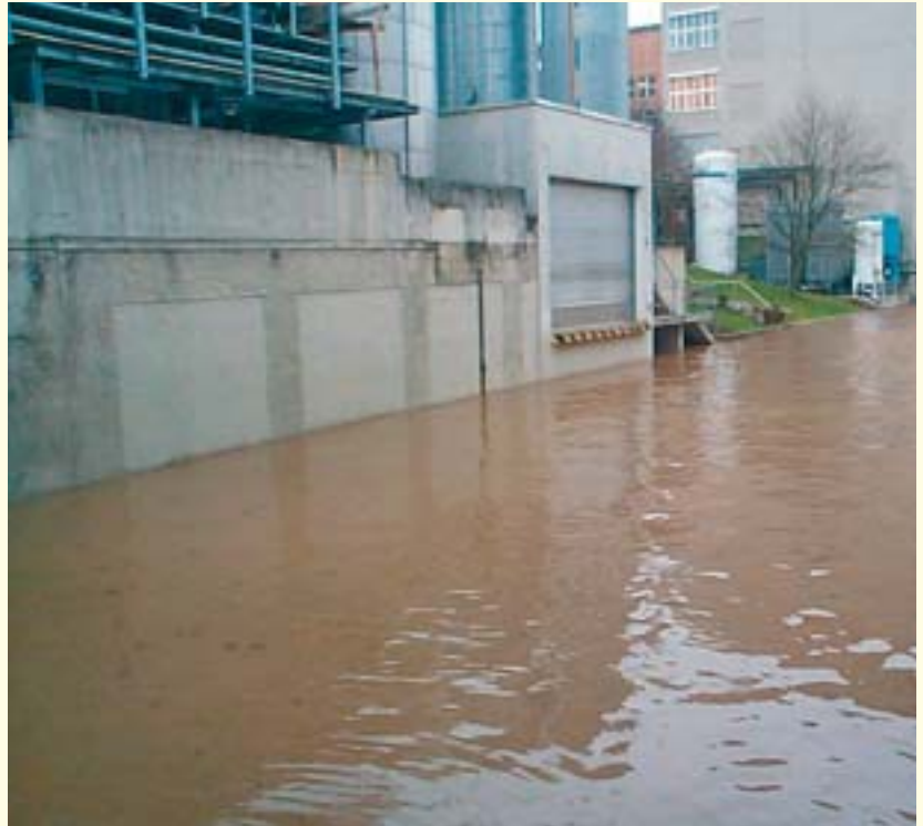
Betriebsteil bei Hochwasser
