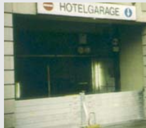
Temporäre Abdichtung einer Tiefgarage.
